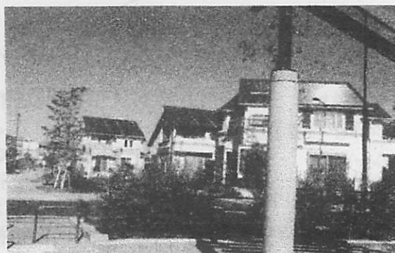
SST中央部の戸建て住宅
