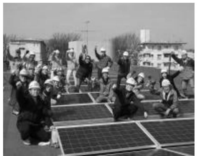
市民と一緒に太陽光パネルを取り付けて完成
