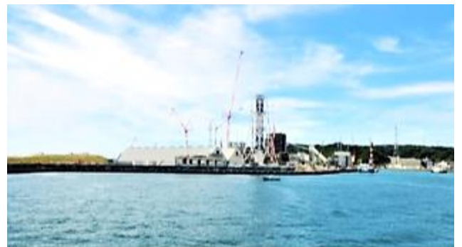
(建設中の発電所、武本匡弘さん提供)
